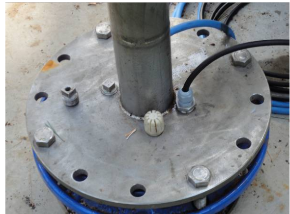
Boring 71.762, opadvendt udluftning
